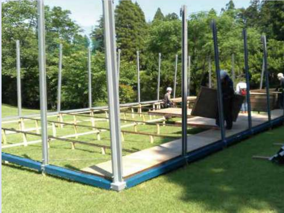
プレハブハウス組立状況
