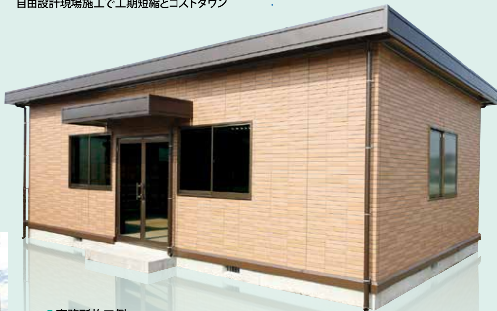
■ 事務所施工例
