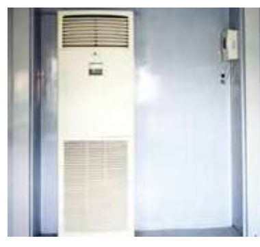
● 3相200V床置型 パッケージエアコン室内機 (3相200V電源)
