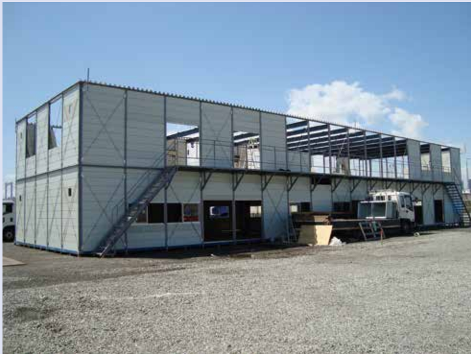
プレハブハウス組立状況
