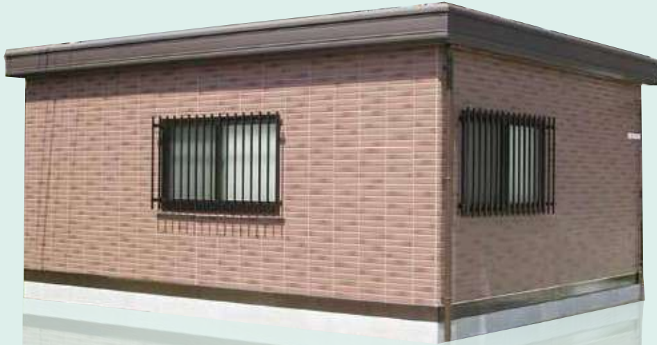
■事務所施工例
